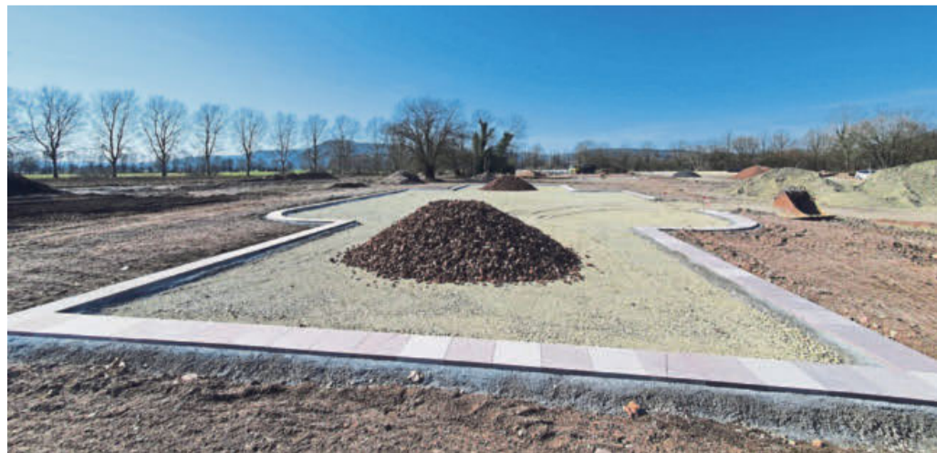
Im Fragenkatalog von „Grün statt Grau“ wollen die Antragsteller auch Details zum Kauf des herzoglichen Sägewerkes in Corvey (hier Bauarbeiten) für den dort geplanten Archäologiepark durch die Stadt für die LGS wissen. Es geht um die Umstände, wie Corvey die Waldflächen der Stadt Höxter bekommen hat. Foto: Michael Robrecht
