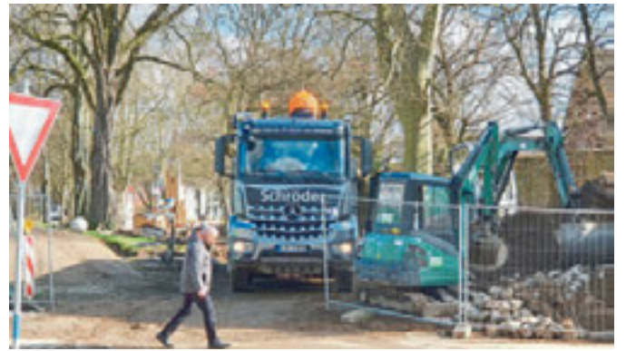
Auf Hochtouren liefen die Bauarbeiten am Wall in den Wochen vor der Eröffnung. Foto: Michael Robrecht
